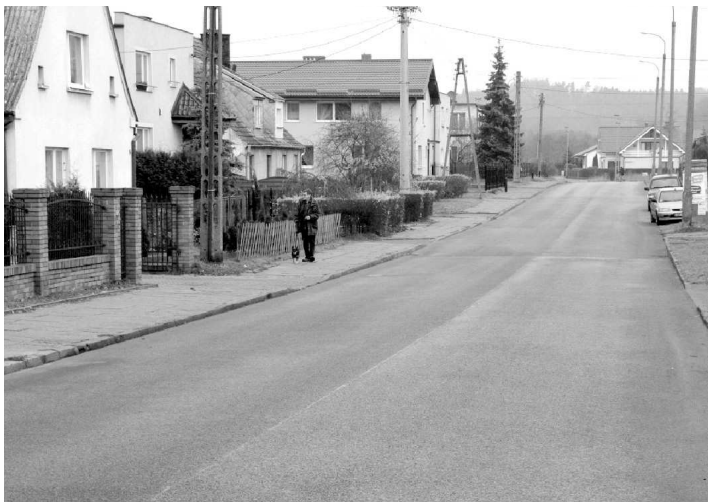
Wyremontowana ul. Obrońców Wybrzeża
