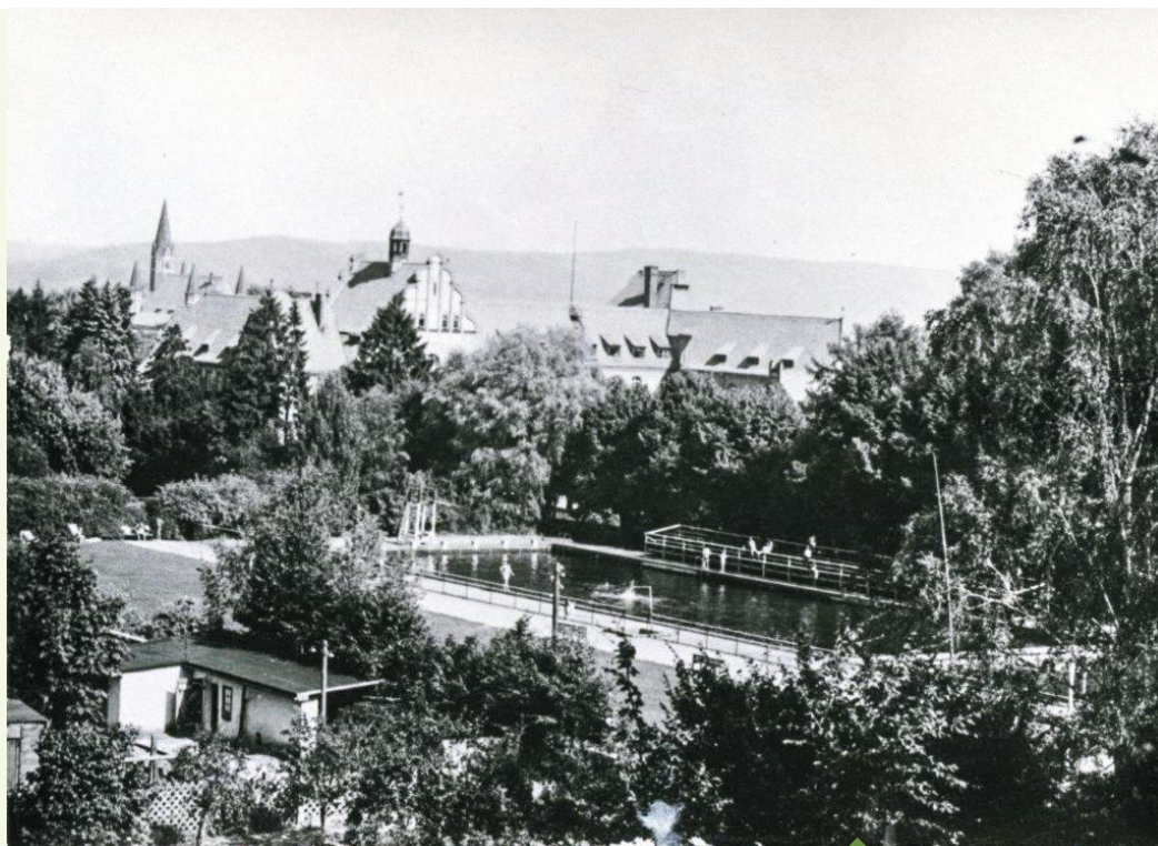
W tle budynek dzisiejszego Zespołu Szkół Ponadgimnazjalnych nr 2 „Elektryk”
